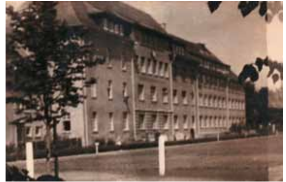
Abb. 6: Rückseite der Fabrik und des Bürogebäudes vom Sportplatz aus gesehen.
