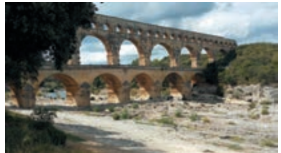
Abb. 7: Pont du Gard, Provence.
