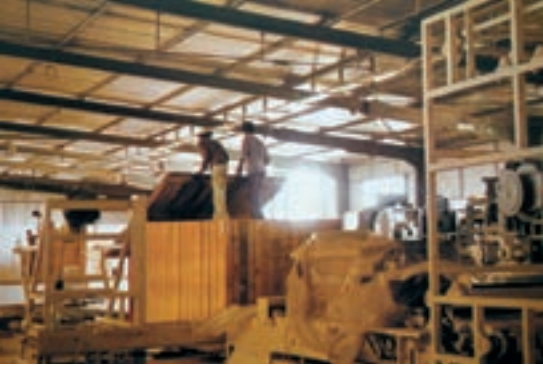
Abb. 13: Winklertechniker installieren eine Bäckereianlage in Saudi Arabien (70er Jahre). Kreisarchiv Schwarzwald-Baar.
