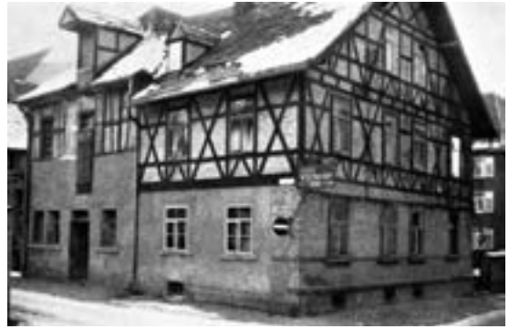
Abb. 2: Das erste Firmengebäude in der Rietgasse. Winkler-Werkszeitung 1, 1963.
