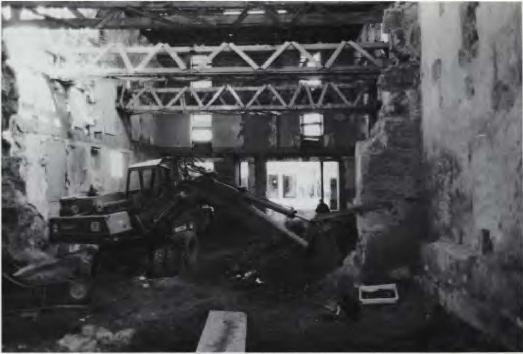
Oben: Der analoge Blick in der früheren Villingener Kirche nach dem Herausbrechen der Vermauerung im Chorbogen. Die links und rechts in den Raum vorspringenden Mauerteile sind die Reste des Chorbogens. Durch die Lichtöffnung der Wand im Hintergrund sieht man auf die Niedere Straße.
