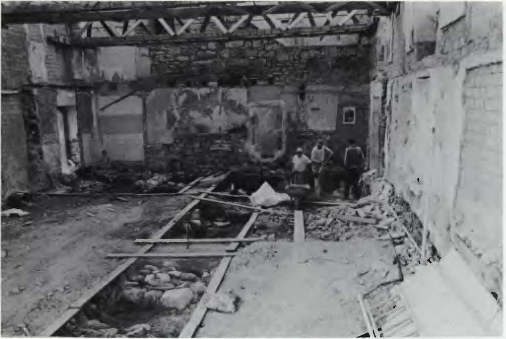
Oben: Und so sah der ehemalige Kirchenraum in Villingen aus, als 1987 das Innere des derzeitigen Geschäfts- und Wohnhauses „ausgekernt“ war. Im Hintergrund ist der ehemalige Chordurchgang noch durch eine später eingebrachte Natursteinvermauerung geschlossen. Unterhalb des Fußbodens treten die ersten archäologischen Spuren zutage.
