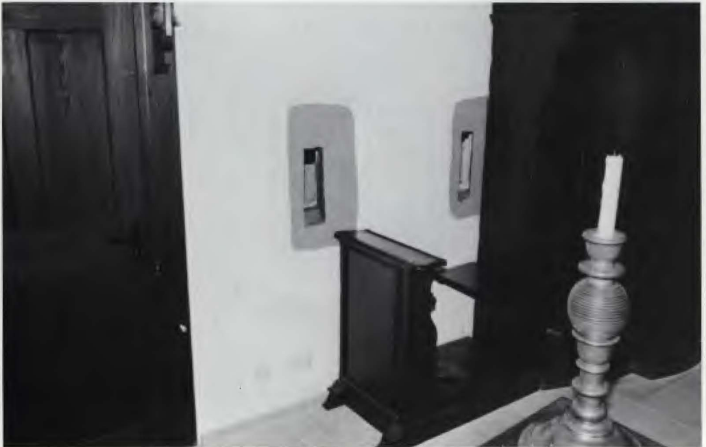
Die „Löcher zum Messehören“ im Obergeschoß des äußeren Chores der Offenburger Kapuzinerkirche. – Wie die Perspektive zeigt, besteht unmittelbare Sichtverbindung Altar – Fensterchen. Üblich sind nur zwei solcher Scharten. Davon befindet sich die eine – für den schwerkrank Liegenden – etwas tiefer als die andere. Das Lichtfenster darunter ist ebenso wie die zwei weiteren, vermauerten Öffnungen im Erdgeschoß nicht zu deuten. Im unteren Bild – dem Chor in Haslach – ist die Ausrichtung der Blickverbindung mit dem Altar durch die Schräganordnung der inneren Fensterleibung unverkennbar; der Kerzenleuchter steht genau auf der Altarecke. Der Raum hinter den Fensterchen war ohne Zweifel zur Teilnahme am Gottesdienst bestimmt, aber wir kennen seine Funktion nicht. Gleichartige Öffnungen hat man in Villingen nicht gefunden.
